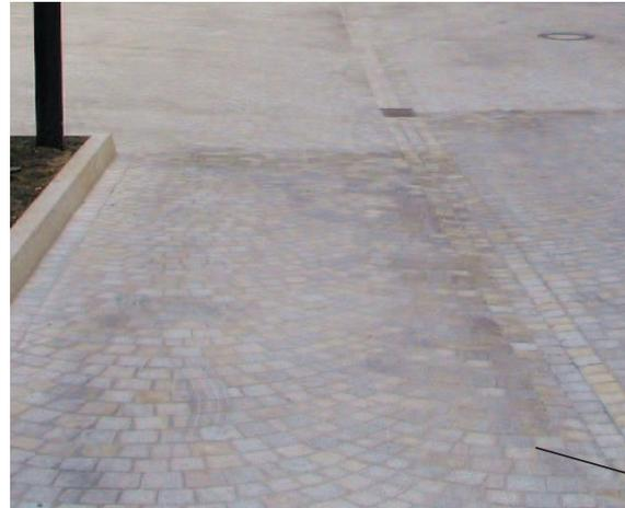
*Trennung Fahrbahn und Gehwege durch 3 zeilige Rinne aus Kleinpflaster*
